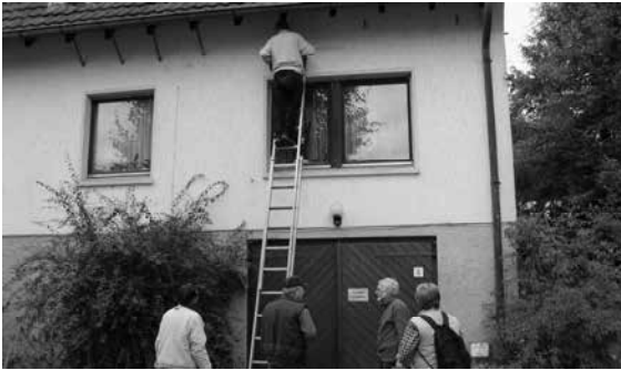
Anbringen von Kotbrettern an schwalbenfreundlichen Häusern.
