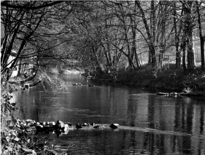
Die Agger bei Ründeroth. Hier wurden Störsteine versetzt in die Agger verbracht, wodurch eine bessere Dynamik im Fluss erreicht wird (Foto und Urheberrechte: Horst Stolzenburg)
