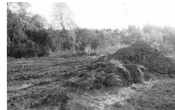
Bodenarbeiten: Mit Bagger-Einsatz wird Oberboden abgeschoben um Arnika, Borstgras und Orchideen neuen Lebensraum zu bieten. Foto: U.Hoffmann
