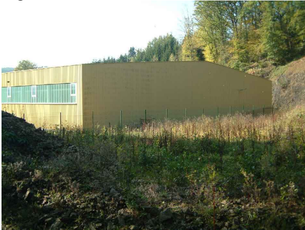
Halle der Fa. Elektrisola
